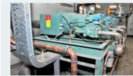
Агрегат на четырех компрессорах Bitzer
